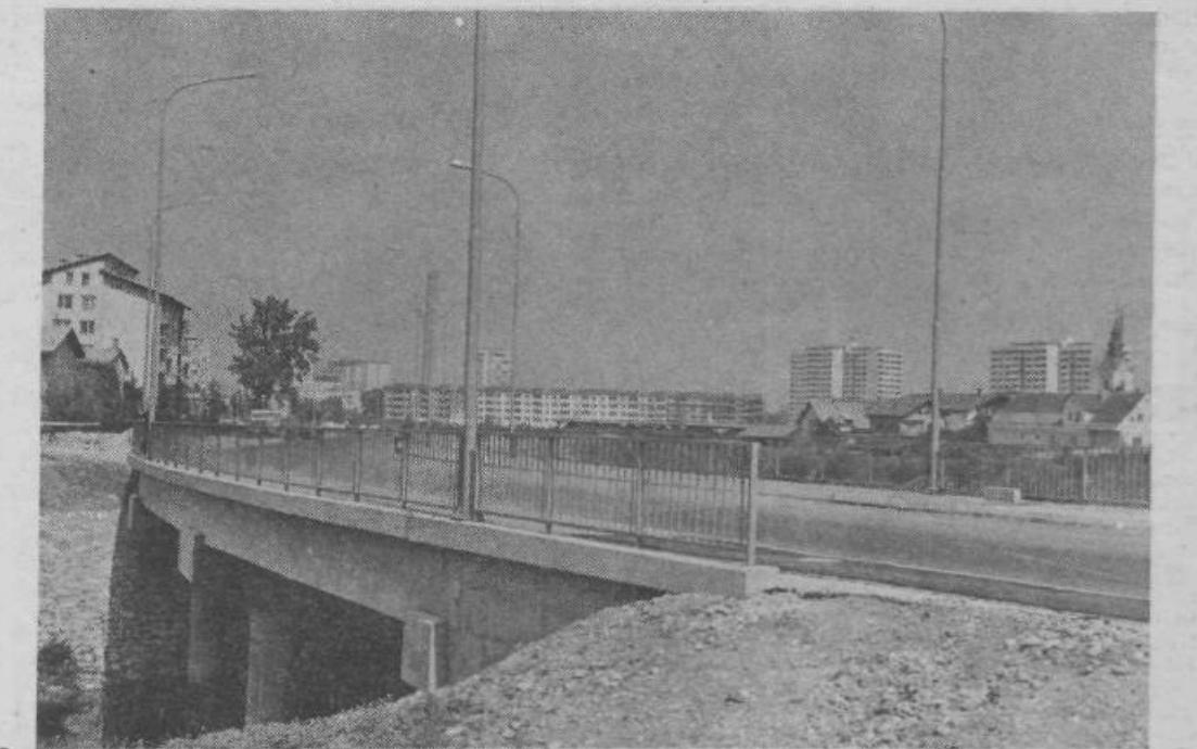
Nov eleganten most čez Gruberjev prekop je ponos gradbincev in prebivalcev Štepanjskega naselja in Gmajne, ki bodo poslej imeli boljše povezavo s središčem mesta. Most je tehnično pregledan, ko bo pa opravljen še tehnični ogled nove ceste, bo izdano uporabno dovoljenje. Po njem bodo lahko vozili tudi najtežji tovornjaki do 60 ton nosilnosti
