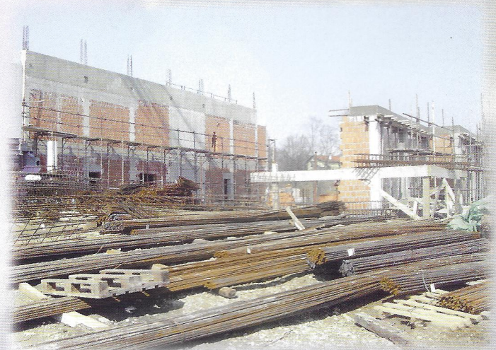
Pripravljena jeklena armatura, ki bo še vgrajena v rastoči objekt
