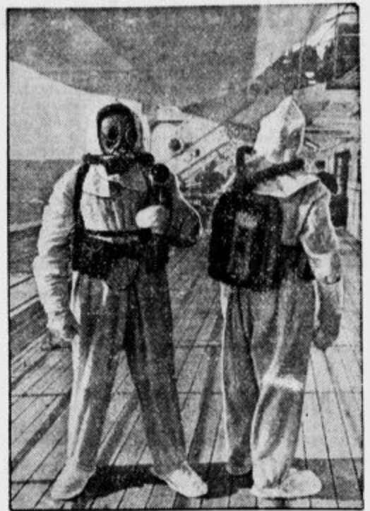
Gasilska obleka iz azbesta, ki ne gori. Tako obleko imajo gasilci na vseh nemških ladjah, da med požarom lahko gasilci pridejo do požara samega.
