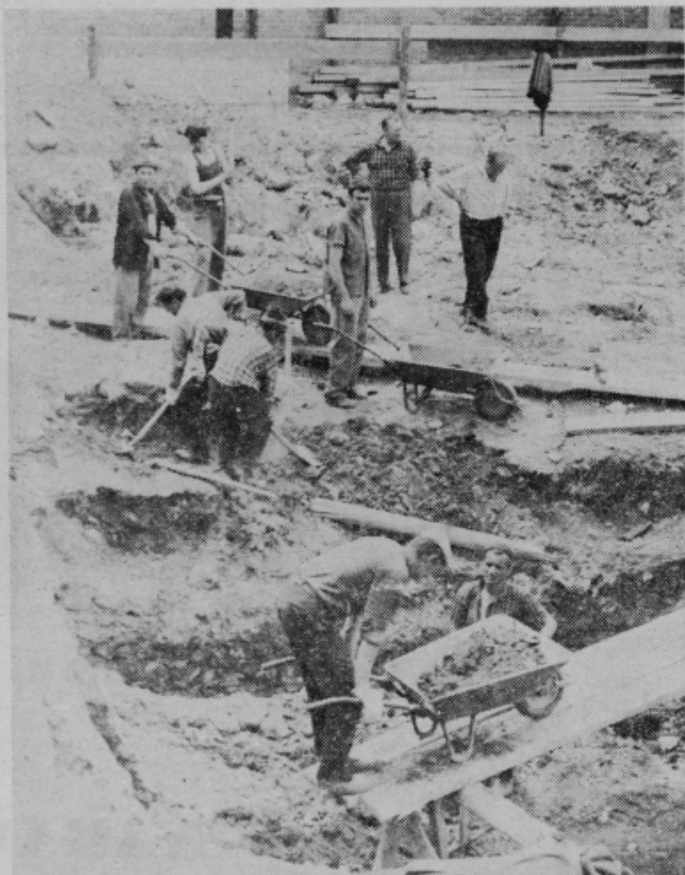
MESTO NAD MESTOM. Pri kopanju temeljev za novo poslovno stanovanjsko poslopje ob križišču Miklošičeve so delavci našli na ostanke rimske Celeie. Delavci muzeja, ki so nemudoma prevzeli strokovno vodstvo pri nadaljnjem odkrivanju so mnenja, da gre za že predvidene ostanke rimskega mesta, ki se raztezajo od Maksimiljanove cerkve pa do Savinje. Doslej so odkrili stare zidove, fragmente stenskih slikarij in dele posode. Foto J. Sever.
