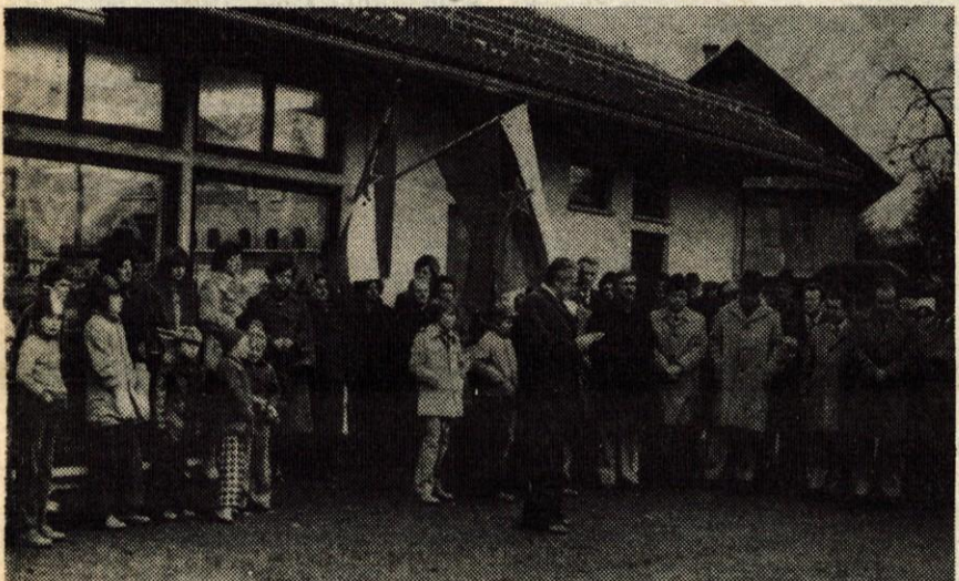
Radovljica — Podjetje Veletrgovina Živila Kranj je v soboto, 26. novembra, v Predtrgu v Radovljici odprla novo samopostrežno trgovino. Prodajni in skladiščni prostori merijo prek 150 kvadratnih metrov. Gradbena dela je izvajalo SGP Gorenje iz Radovljice, gradnja z vsemi drugimi stroški pa je veljala prek 3,5 milijona dinarjev. Izgradnja te trgovine je bila potrebna, saj prebivalci Predtrga doslej niso imeli urejene preskrbe z živili. Trgovino je odprl predsednik sveta KS Radovljica Jože Rebec. — A.Ž. — Foto: F. Perdan
