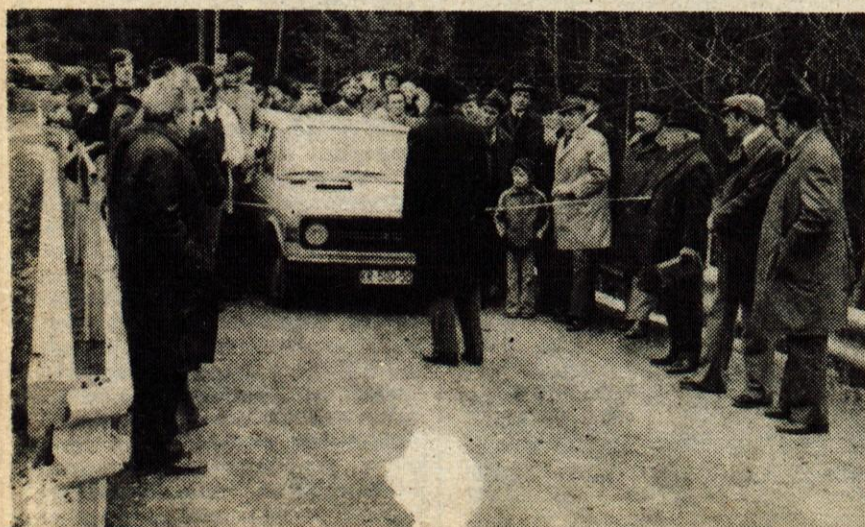
V nedeljo so v krajevni skupnosti Podnart svečano odprli most in cesto Češnjica-Dobravica. Most in cesto je odprl Ciril Rozman. — Foto: F. Perdan
