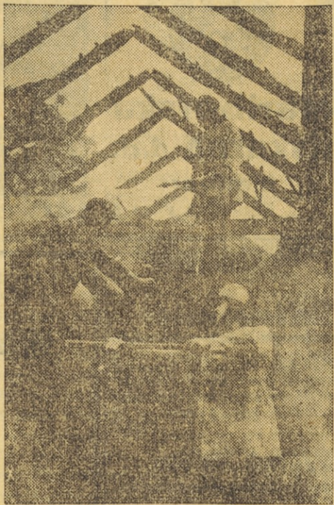
Ein durch britischen Bombenschlag zerstörtes Wohnhaus in einem nördlichen Vorort in Berlin
