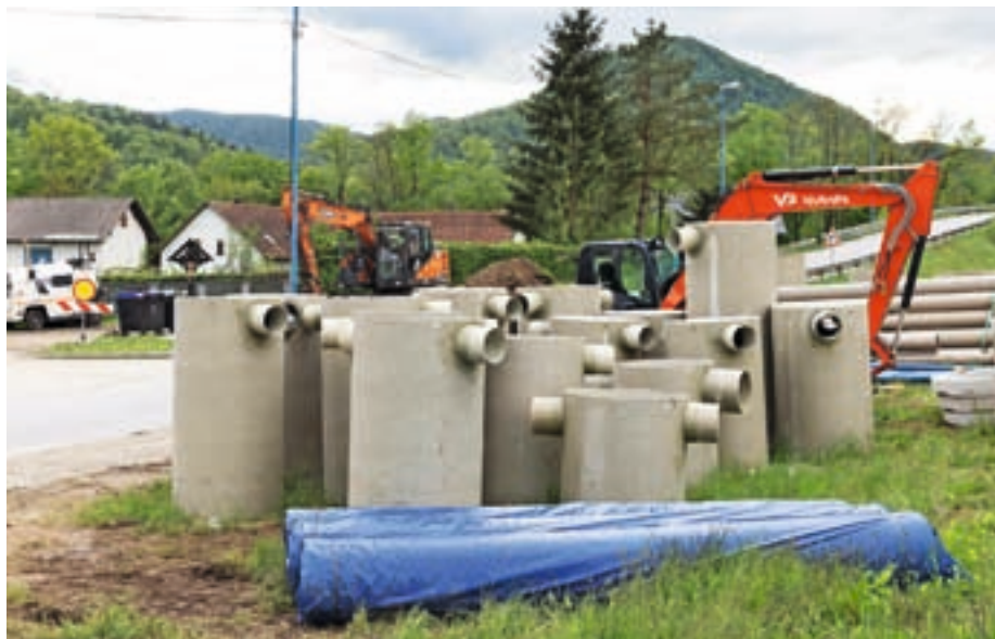
Na Ladji bo izvajalec zgradil 1200 metrov kanalizacije in obnovil 490 metrov vodovoda. / Foto: Peter Košenina
