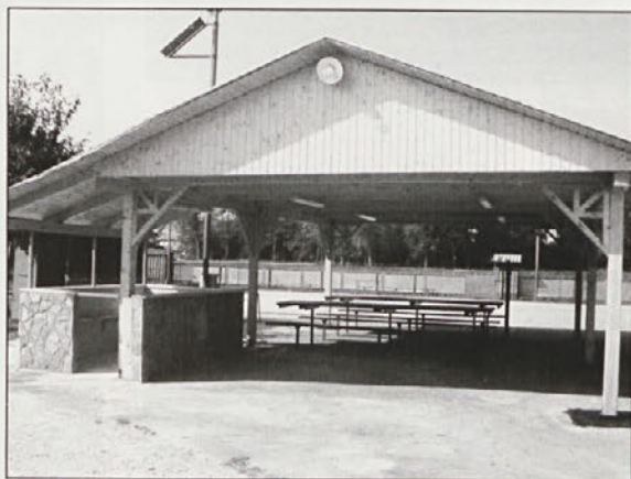
Nova nadstrešnica trževskih športnikov.
