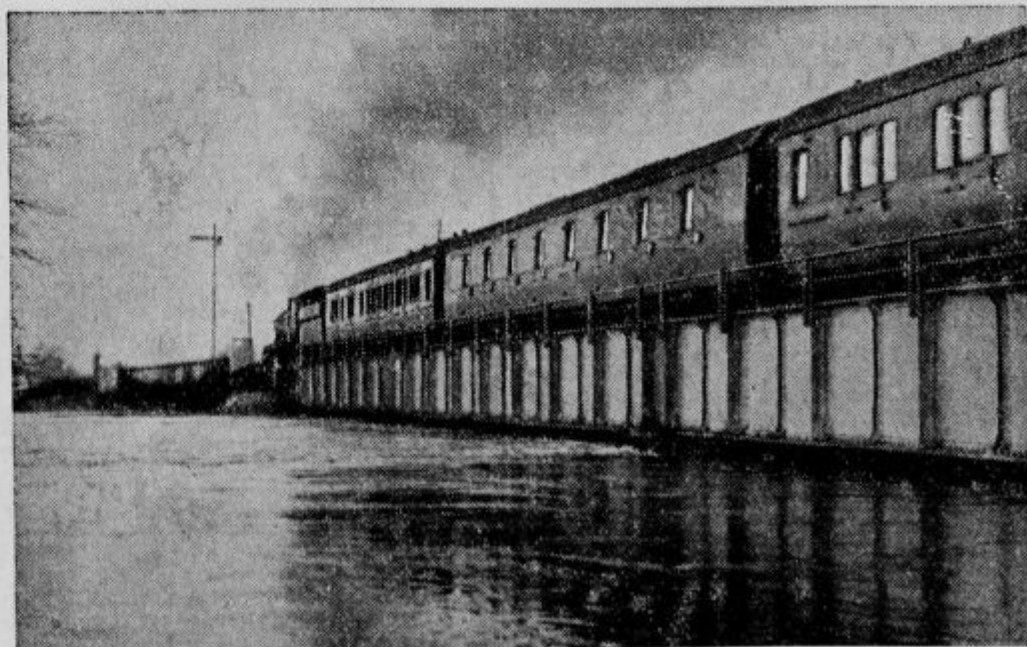
Slika s povodnji na Angleškem. Železniški most pri Exteru je v nevarnosti.
