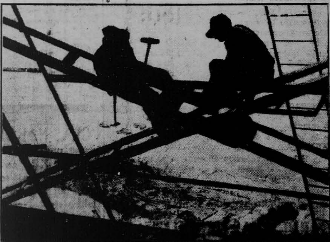
Orajo vršiti delavci pri nasipu Cove Creek v državi Tennessee. Slika nam kaže dva delavca, zaposlena pri železni konstrukciji, čisto čevljev nad Clinch reko.
