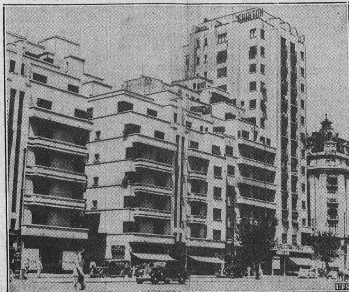
Carlton, nebotičnik v Bucharesti, ki ga je sesul potres zadnjo nedeljo. Do 300 oseb je našlo smrt v razvalinah; 72 trupel so že izkopali. Potres je zahteval v Rumunski nad 2,000 človeških žrtev.
