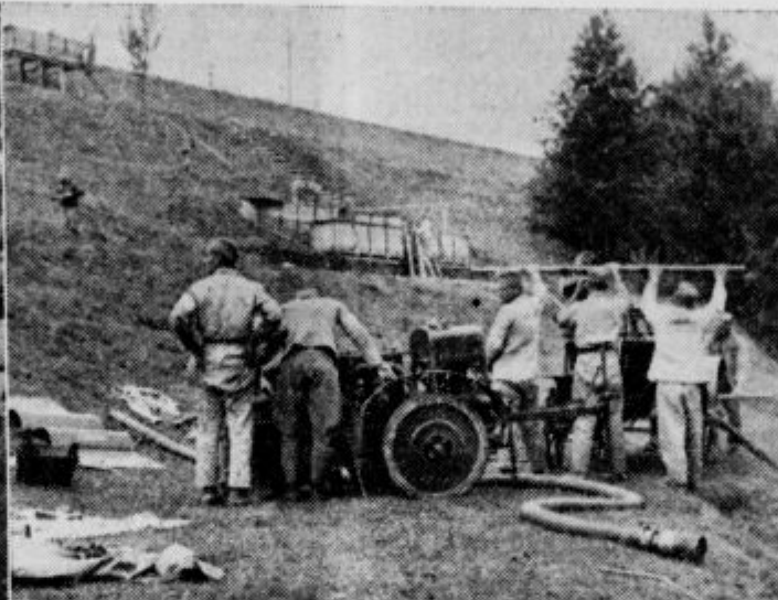
V zgodnjem jutru pospravljajo pešči šotore, pod katerimi so prenočili pod kozolci v Vavti vasi. — Vodna postaja ob Latini pri Sv. Marjeti. Z ročno in motorno črpalko, ki so jo dali na razpolago gasilci iz Gradca, črpajo vodo v velike lesene rezervoarje na bregu. V njih se voda čisti in razkužuje. Postaja mora priskrbeti v 8 urah 60.000 litrov zdrave in okusne vode. — Planinci so prav posebni mojstri maskiranja svojih enot. Tako je oddelek planincev prenočeval v Soteski, pri čemer je bila večina šotorov postavljenih v skladišču lesa, ki so ga večje izkoristili. Vsi šotori so bili pokriti z deskami, tako da tudi najbolj bister »sovražnik« letalec ob skladišču ne bi mogel opaziti ničesar
