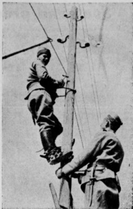
Po vsem razsežnem manevrskem ozemlju so posebne telegrafске čete napeljele goste telefonsko in telegrafsko mrežo. Telegrafisti pritrujejo ob že obstoječem telef. vodu zasilno telefonsko linijo
