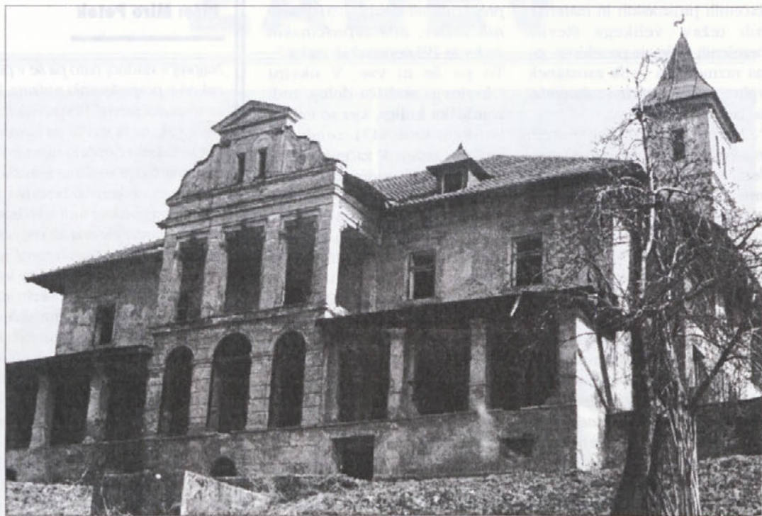
Pročelje gradu je vidno načel zob časa. Kako naprej?
