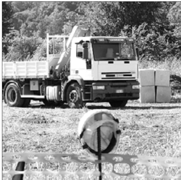
Gradbišče novega parka
