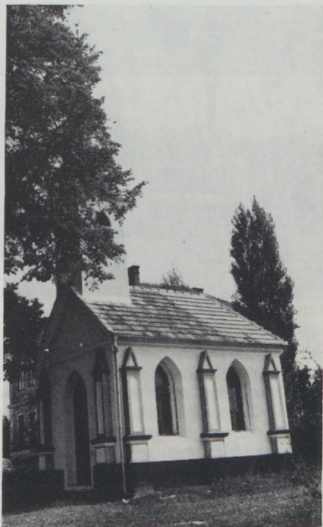
Obnovljena kapela Srca Jezusovega na Stari cesti
