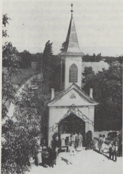
Obnovljena kapela v Stročji vasi
