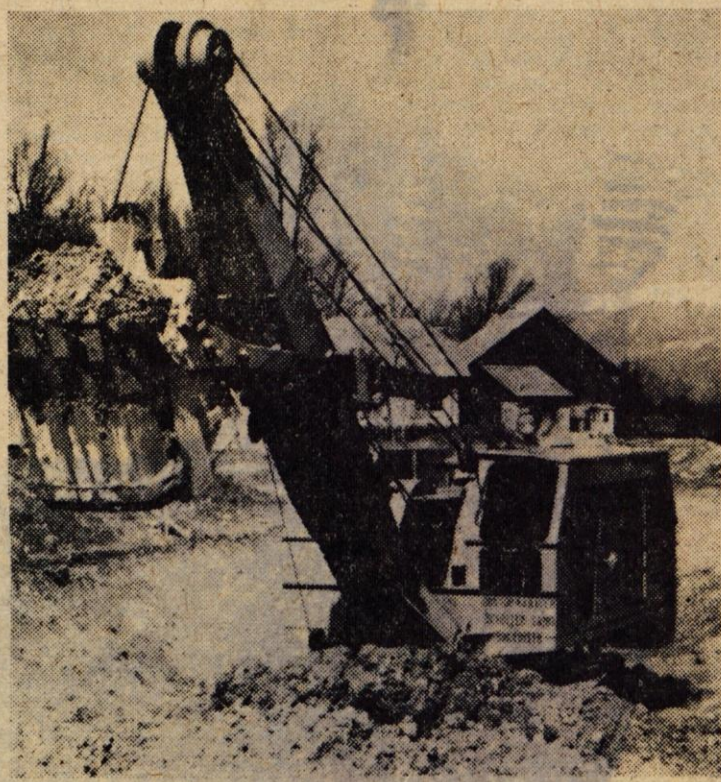
Skoraj v vseh krajih, skozi katere bo tekla nova elektrificirana železnica, se bo nekaj spremenilo. Na Orešku bo na primer kilometer nove proge, ki bo ublažila zavoj, zato bo treba precej izkopa, podreti pa so morali tudi eno hišo
