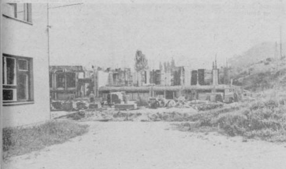
Ob sedanji zgradbi občinske stavbe raste nova. V njej bo našlo prostor temeljno sodišče in milica ter sodnik za prekrške.
