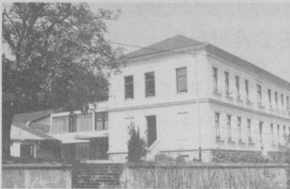
Pogled na stari in novi del osnovne šole
