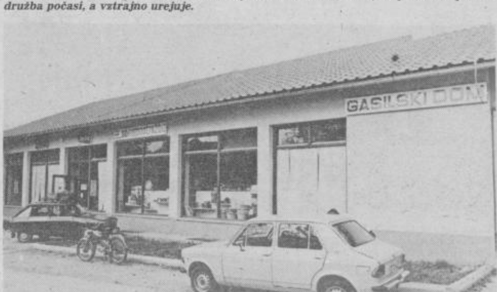
V Kostivnici so pričeli graditi tudi osnovno šolo, v njej pa bo v štirih učilnicah prostora za 120 učencev. Ker je voda nagajala te dni, je izkopana le gradbena jama in za fotografski posnetek premalo mikaven motiv. Raje smo posneli nov vaški dom, v katerem je trgovina, gasilski dom in sploh vsi vaščani najdejo v njem prostora za svoje interesne dejavnosti.
