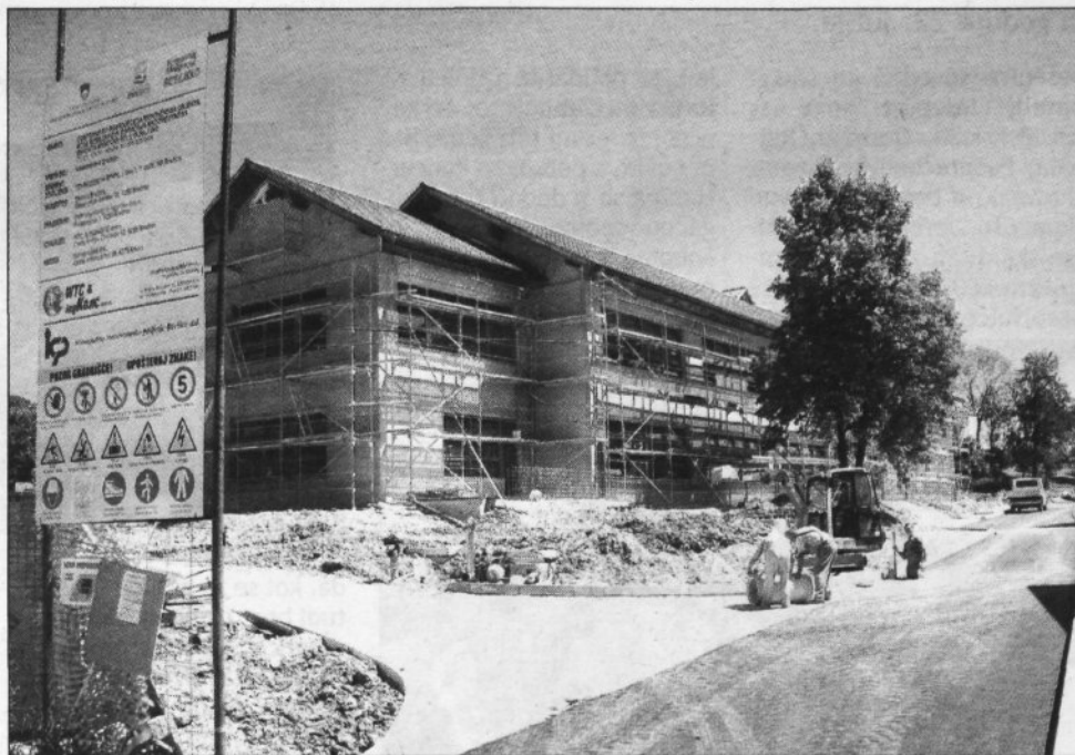
Gradbišče ne kaže, da bo šola končana v roku.
