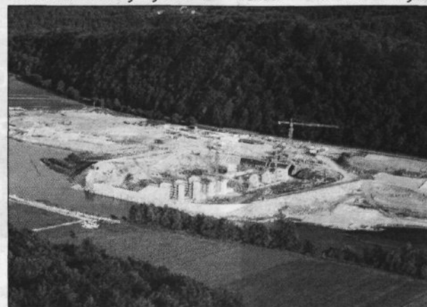
Gradbišče HE Blanca
