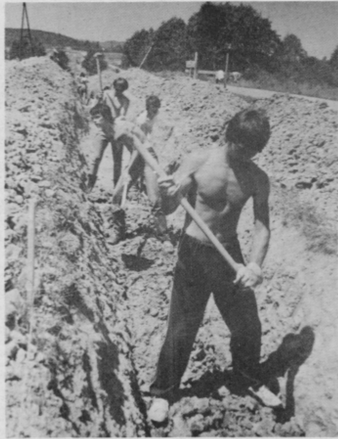
Kljub vročini so vztrajno poglobljali vodovodni jarek in presegali dnevne norme Foto: OM
