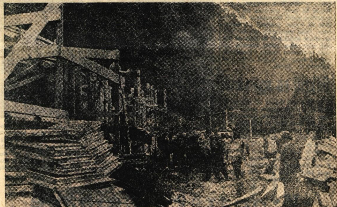
Gradnja novega poslojja Zavoda za socialno varovanje — podružnica Tržič hitro napreduje. Če ne bo večjih vremenskih nepravil, računamo, da bo nov objekt še letos pod streho. V novem poslojju bodo pisarniški prostori, razen tega pa tudi tri stanovanja
