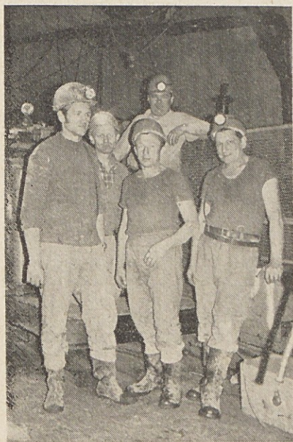
Skupina naših sodelavcev OSRD pri gradnji ventilacijskega jaška na gradbišču Motto di Dentro v Švici.
