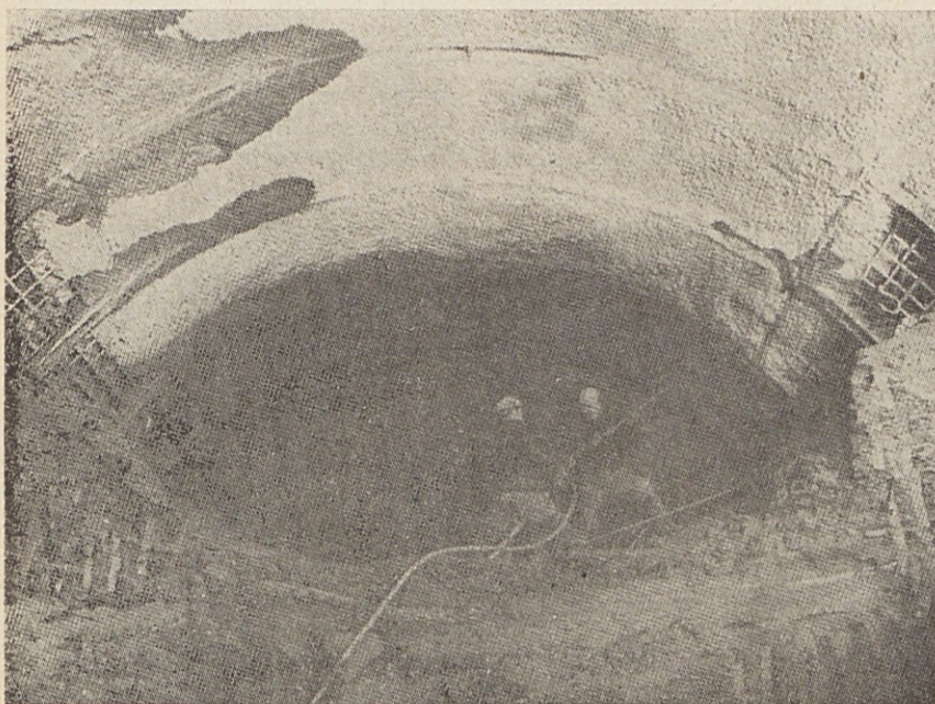
Nanašanje vbrizganega betona v stropnem loku na mrežno armaturo.
