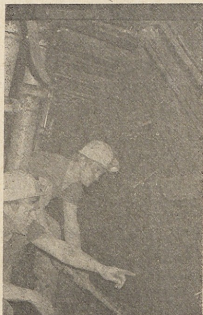
Pridobivanje premoga iz nadkopnega dela pri podporju Salzgiter, v jami Hrastnik.
