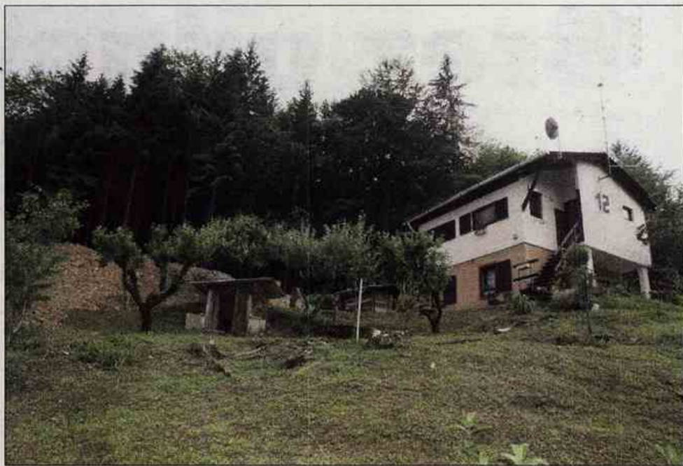
Domačijo Jurkoškovih na idiličnem hribu v Zvodnem ogrožajo hudourniške vode.
