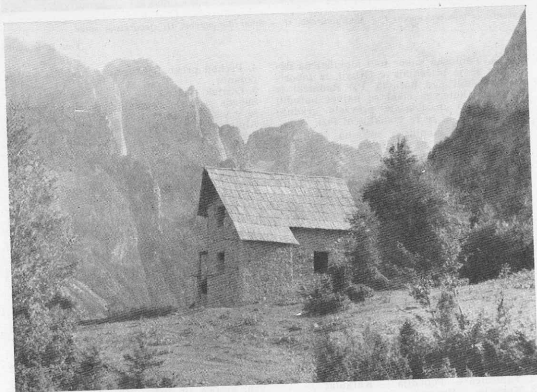
Planinska koča v dolini Grbaje med gradnjo
