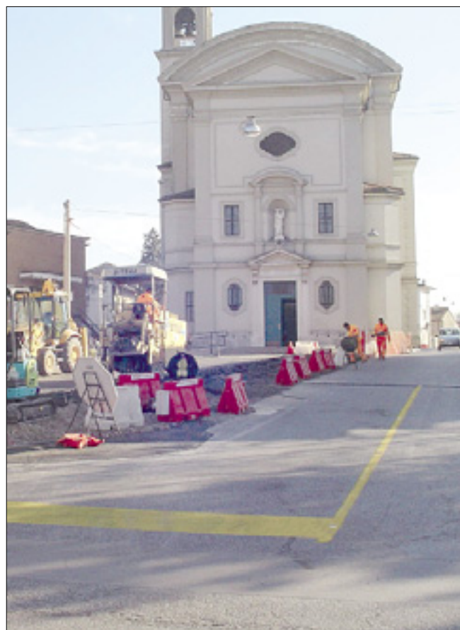
Gradbišče na trgu pred cerkvijo
