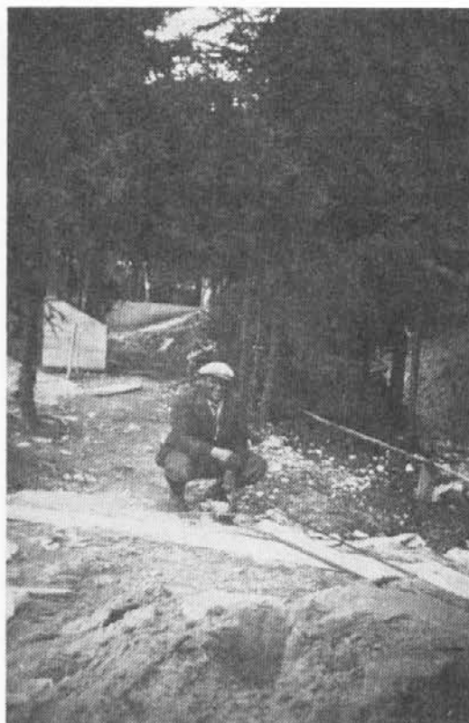
Mežiški tesarski in gradbeni mojster Jurij Potočnik pri izmeri za kopališče
