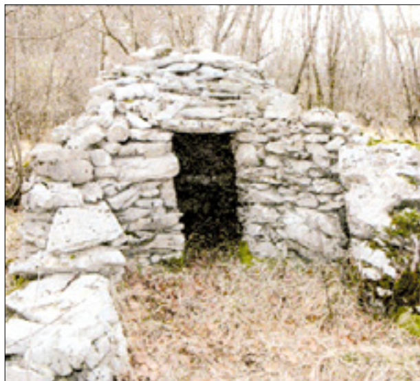
Pastirska hiška - primer tipične kraške kamnite gradnje
