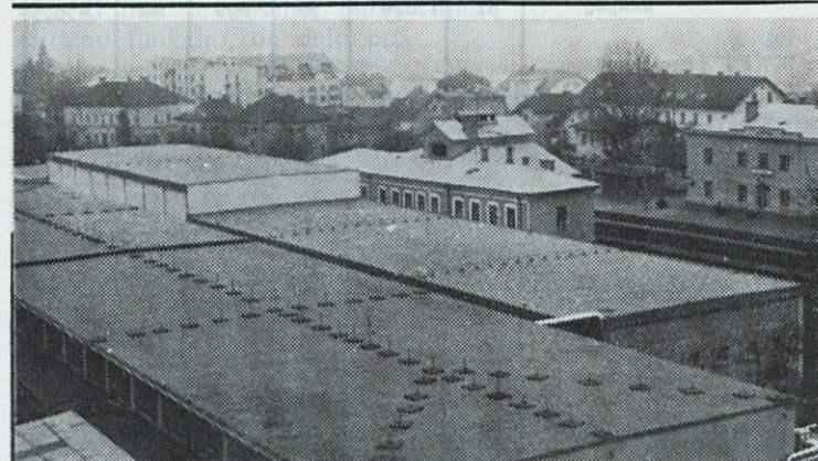
Skladišča in zgradba mešalnice vlaken so zavarovana pred strelo s strel vodno zaščitno mrežo, ki je na fotografiji dobro vidna.
