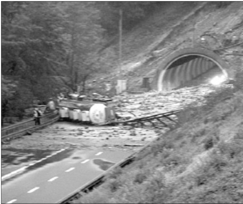
Zemeljski usad na avtocesti A12 blizu La Spezie
