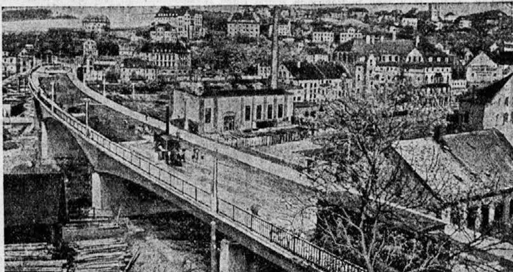
Najdaljši železobetonski most v Evropi. Zgradili so ga pred kratkim v nemškem mestu Aue. Dolg je 305 metrov.
