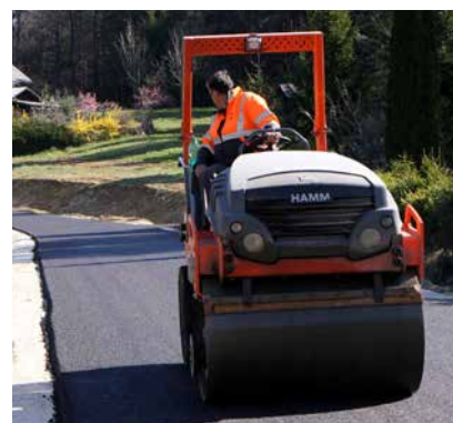
Pri asfaltiranju ceste v Založah sredi aprila
