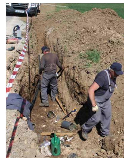
Pri obnovi namakalnega sistema Breg
