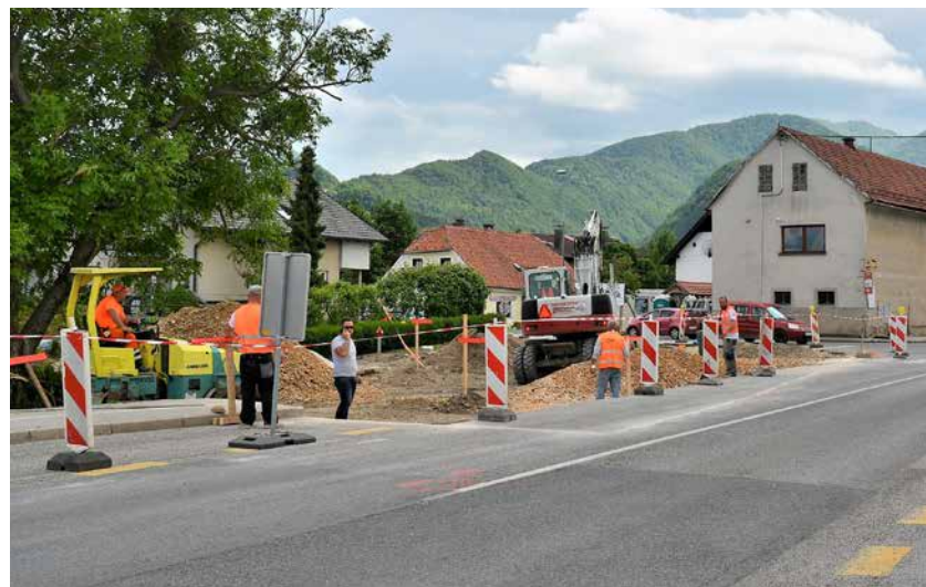
Začetek izgradnje krožišča v izvedbi VOC Celje
