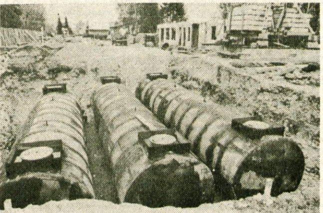
Poglavitni razlog temeljite prenove bencinskega servisa na Zlatem polju je zamenjava rezervoarjev, ki bodo poslej dvoplaščni in ekološko neoporečni. Foto: F. Perdan
