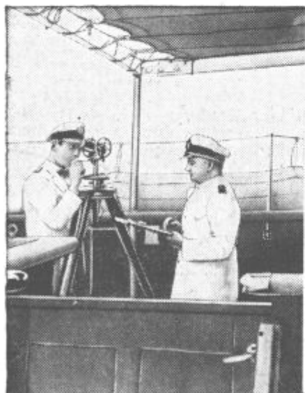
Opazovanje vremena na odprtem morju Opazovanje merilnega balona skozi teodolit
