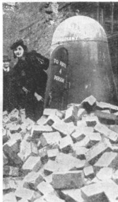
NI STRAHU PRED BOMBAMI! V Birminghamu so napravili poskus z jeklenim zakloniščem proti bombnim napadom. Zaklonišče, v katerem je prostora za štiri osebe, je pri napadu ostalo popolnoma nepoškodovano
