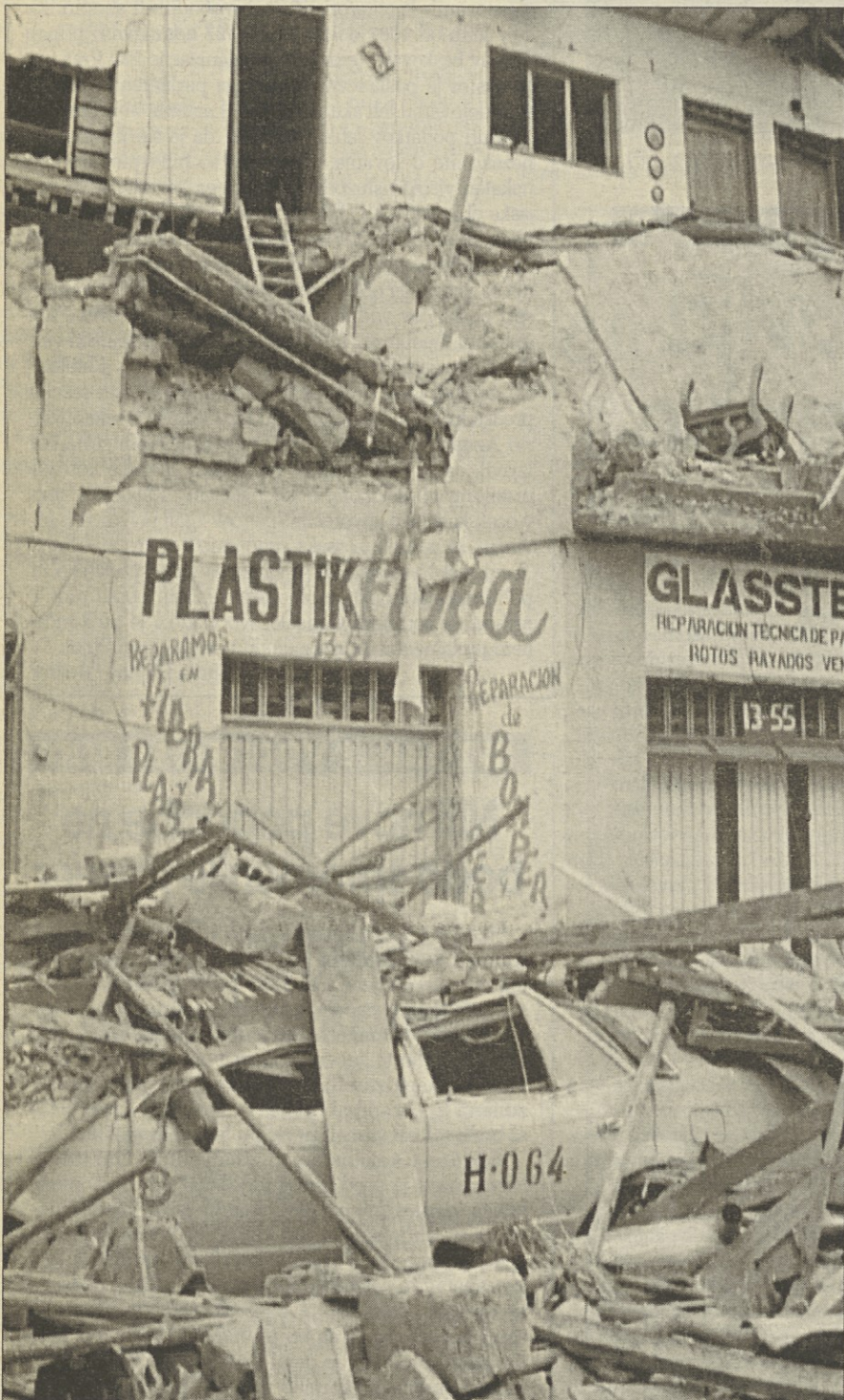
Potresni sunki so povzročili ogromno škodo: ta taksi je na primer ostal pod ruševinami
