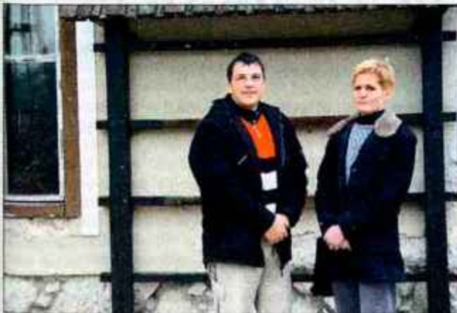
Tomaž Mikolič in Vesna Paljč pred propadajočim pročeljem Kazine.
