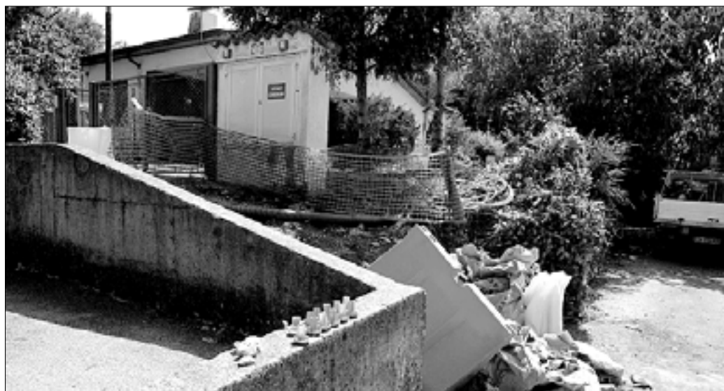
Gradnja novega prehoda med telovadnico in osnovno šolo
