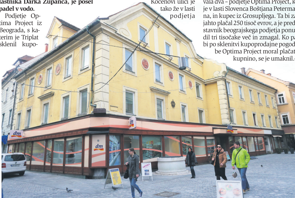
Podjetje Inversio bo v prenavo stavbe v Prešernovi ulici 7 vložilo približno 1,6 milijona evrov. »Stavbi želimo povrniti podobo in sijaj, ki ju je nekoč že imela,« pravi direktorica Simona Lebar.
