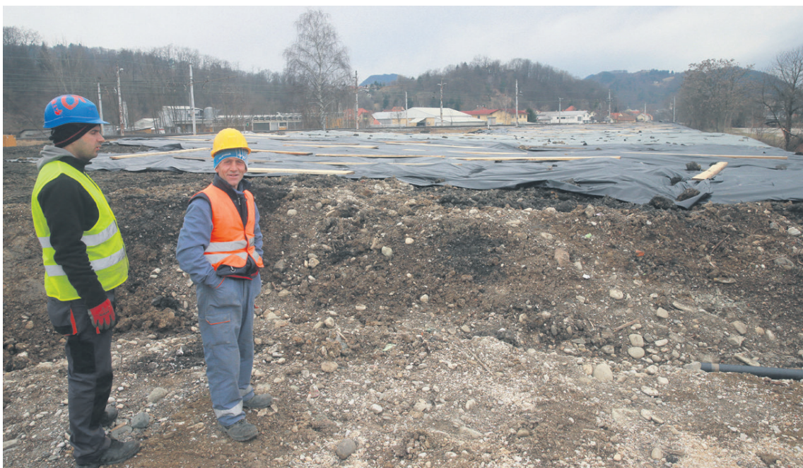
Zemlino z industrijskimi odpadki načasni deponiji izvajalec del začasno prekriva s PVC-folijo.
