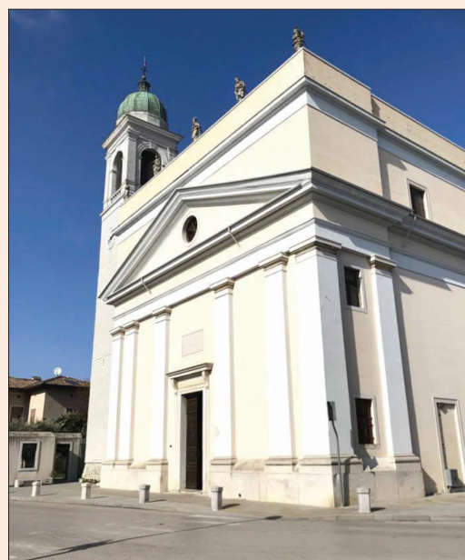
Obnovo cerkve sv. Blaža v Terzu pri Ogleju je leta 1804 začel Jožef Braunizer iz Kanala.
