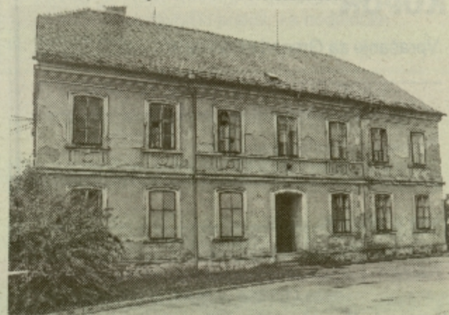
Za obnovo 124 let stare šolske zgradbe bi potrebovali 20 milijonov tolarjev.
