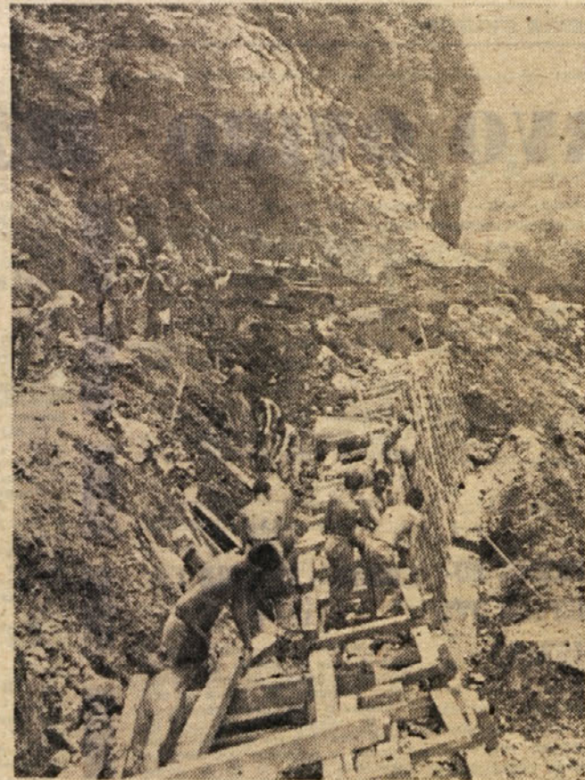
Trasa nove Zasavske ceste je eno samo gradbišče
