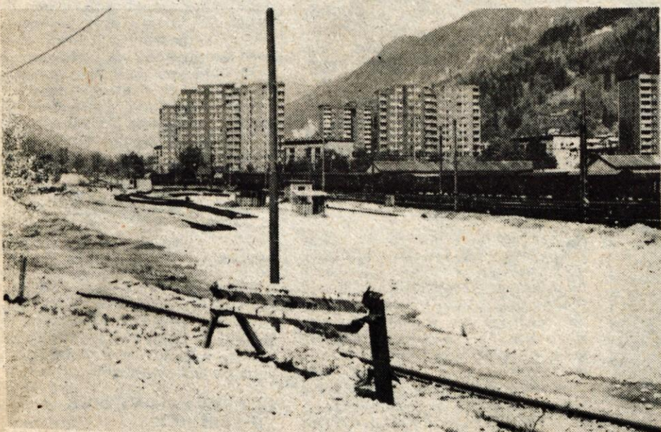
JESENICE — Na zahodni strani jeseniške železniške postaje gradijo delavci nove železniške tire, tovarno skladišče in krmilni hodnik ...
