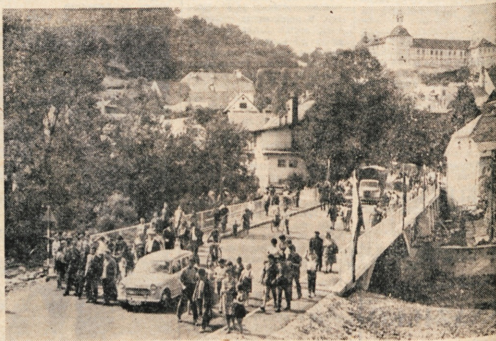
V petek, 30. avgusta, so v Pušalu pri Škofji Loki odprli nov betonski most prek Poljansčice. Težko pričakovani prometni objekt, brez katerega si ni moč zamisliti normalen razvoj južnega dela škofjeloške občine, je dolg 70 metrov, njegova nosilnost pa je 60 ton. Stroški izgradnje so znašali 75 milijonov starih din. Most je odprl predsednik skupščine občine Škofja Loka Zdravko Krvina. — Foto: F. Perdan
