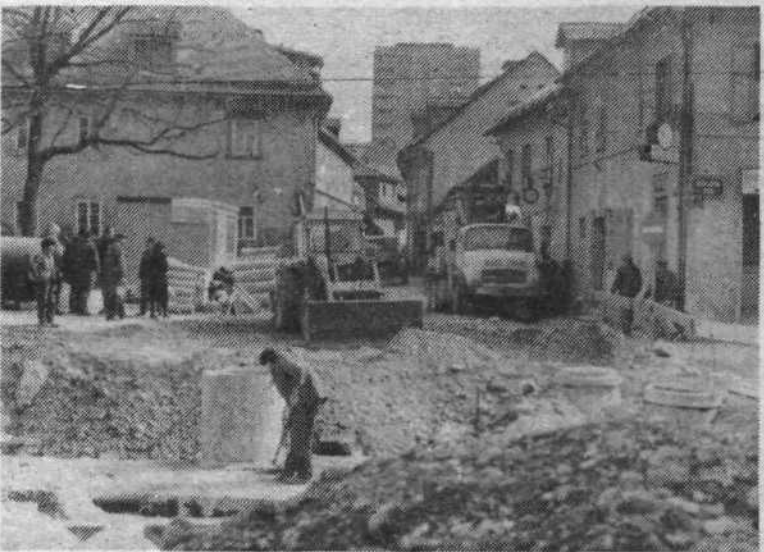
Po vestih iz Komunalne skupnosti Ljubljana Center se bodo kmalu nadaljevala končna dela na Trubarjevi cesti – odesek Rozmanova–Rešljeva cesta.
