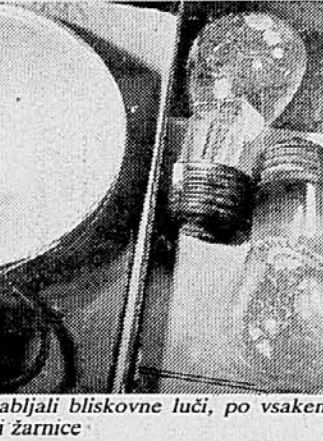
Do petdesetih let so uporabljali bliskovne luči, po vsakem posnetku so morali menjati žarnice
