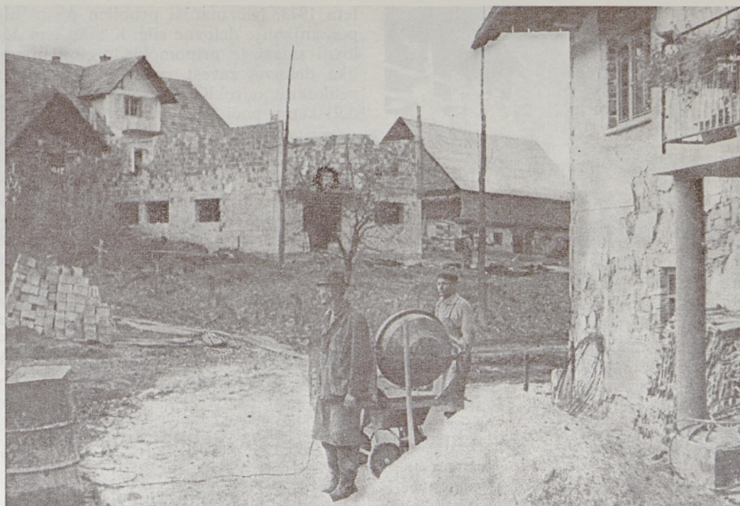
Letošnja mila zima je prav prišla tudi prebivalcem od potresa prizadetega Kozjanskega. Vso zimo so lahko nadaljevali z obnavljalnimi deli na zgradbah
