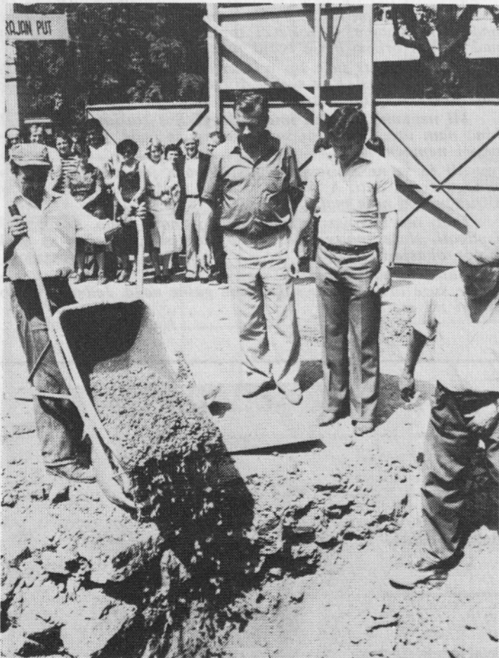
Temeljni kamen je vzdán. Začela se je gradnja.
