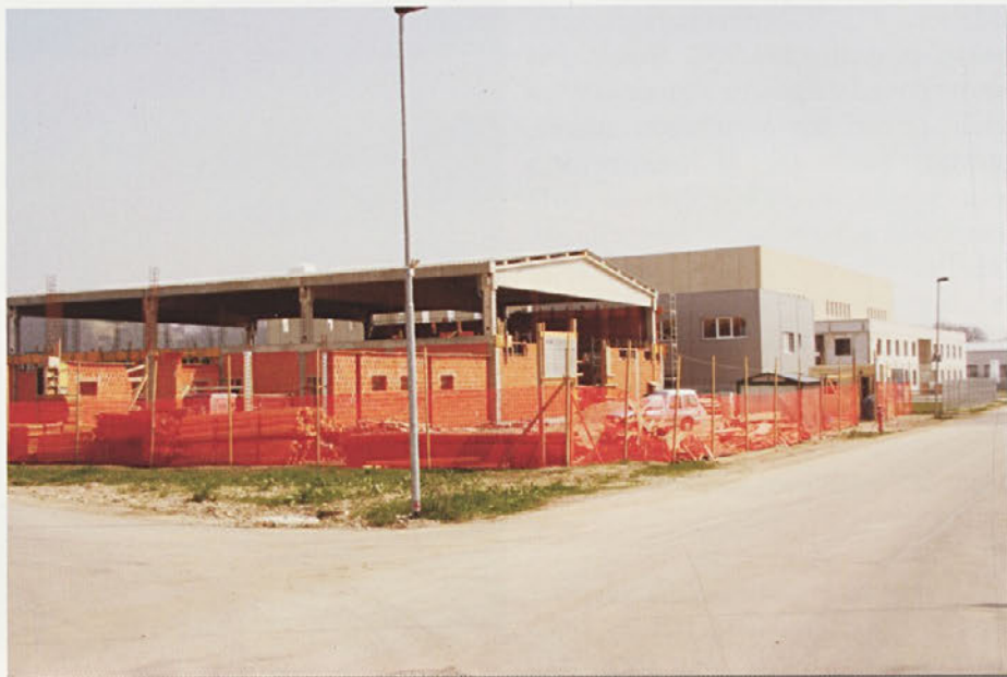
Zasedena je tudi industrijska cona Moškanjci
