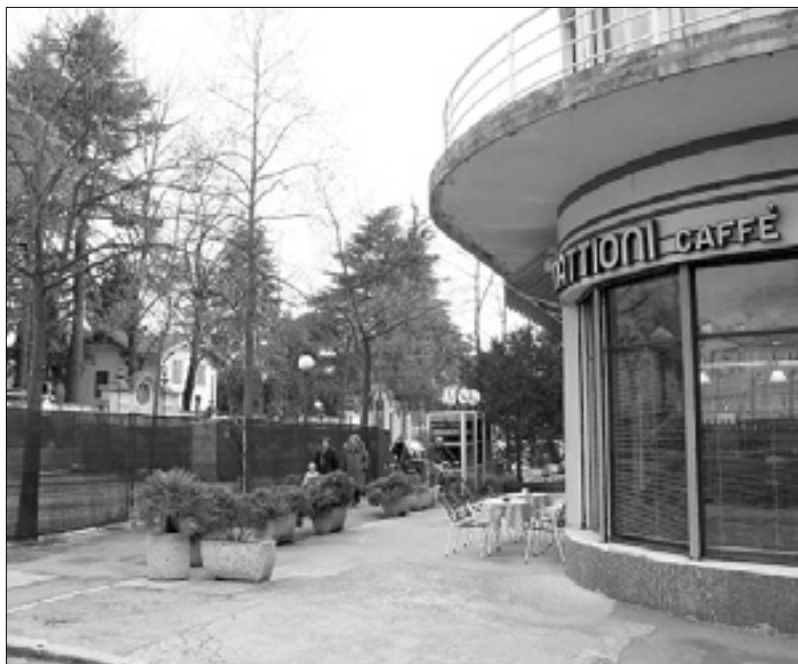
Gradbišče pred Roman barom
