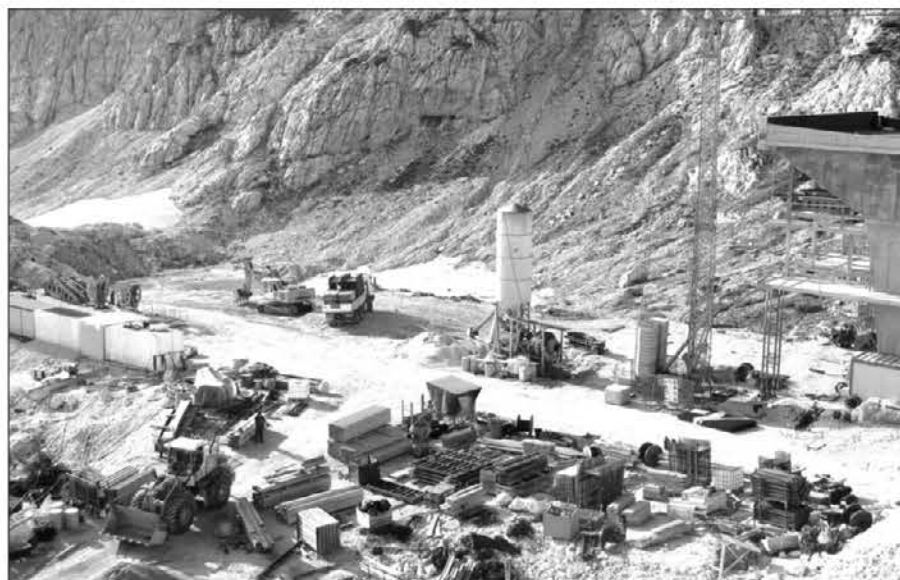
Na vrhu dolina Prevala s kočjo Gilberti, ki skriva gradbišče, tu pa pogled na "kantier"
