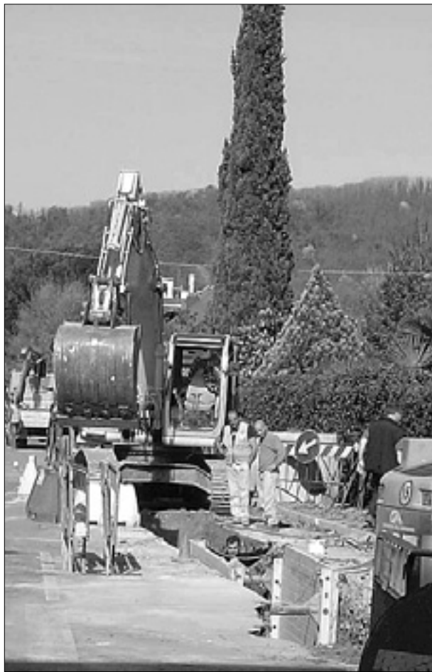
Nameščanje kanalizacijskih cevi v Ulici Carnia
